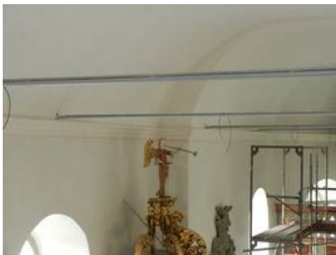
Das Einmessen der Leuchten erfolgte mit Lasertechnik
